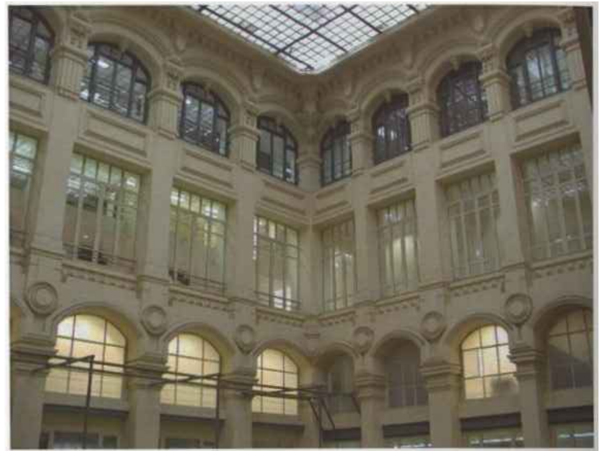
SALA DE BATALLA ANTES REHABILITACIÓN
