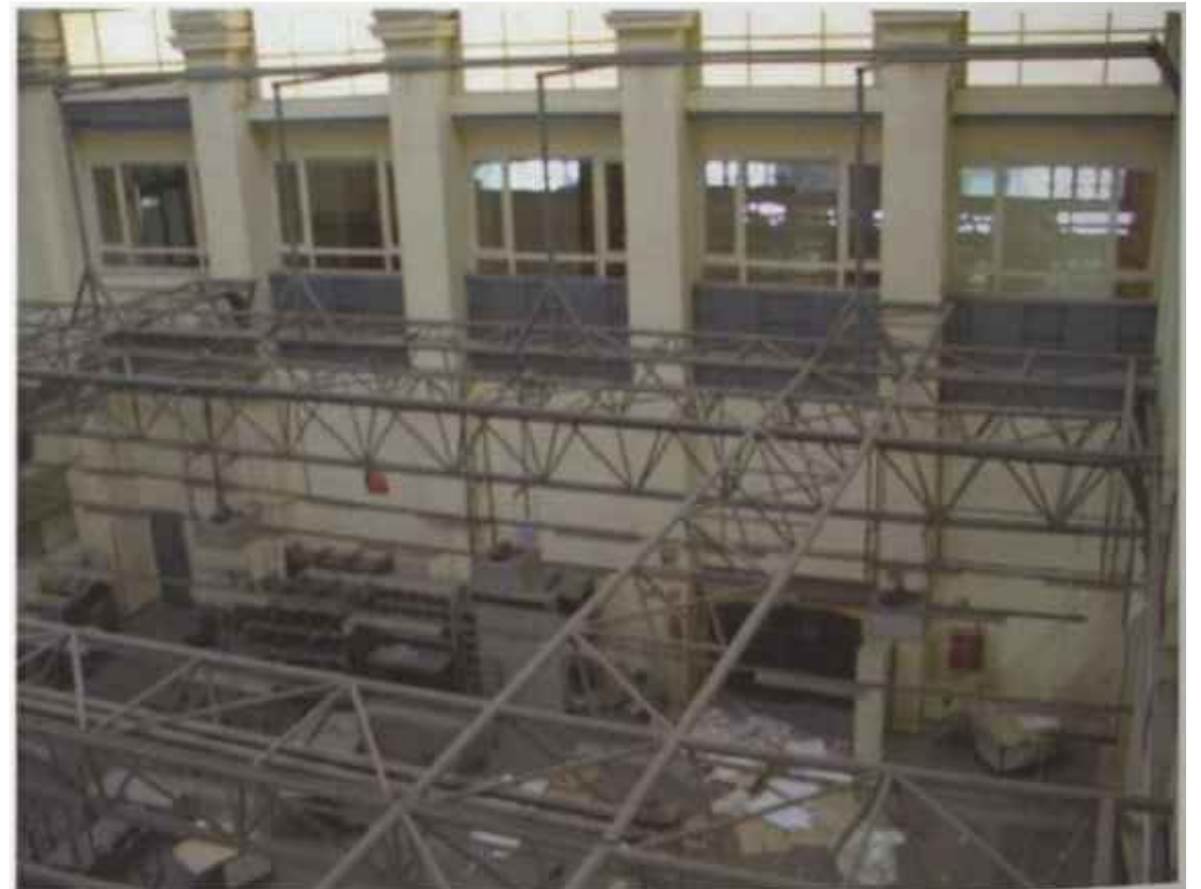
SALA DE BATALLA ANTES REHABILITACIÓN
